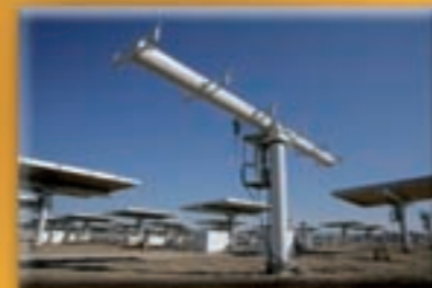
Ensamblaje de columna y viga transversal.
