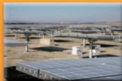
Vista general de un parque en construcción.
