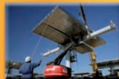
Montaje mecánico y conexión de megamódulos.
