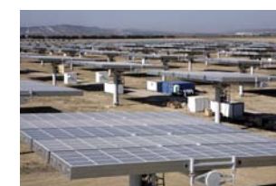
OTROS PARQUES EN CONSTRUCCIÓN 6,5 MW- 260 seguidores
