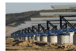
OTROS PARQUES EN CONSTRUCCIÓN 35 MW- 3320 seguidores
