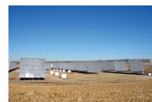
PARQUE SOLAR DE VILLAFRANCA I-II (Navarra) 5 MW- 200 seguidores
